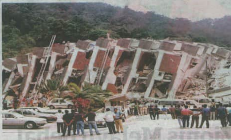
RUNTUHAN Highland Towers pada 1993 menjadi amaran yang pembangunan tanpa keselamatan pasti rapuh.
